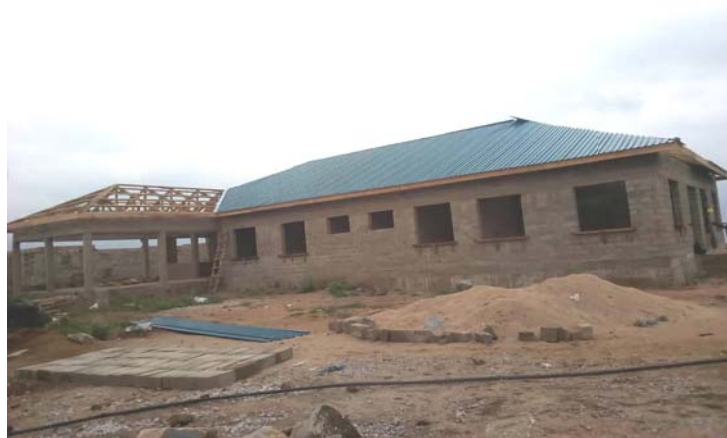
Moja ya Majengo ya Hospital ya Wilaya inayojengwa katika Kitongoji cha Kwikonero, Kijijini Suguti, Kata ya Suguti
